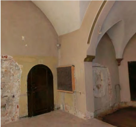
Renovierungsvorbereitungen Foto: C. Lang
